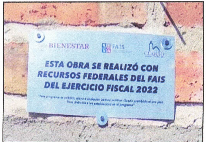
INSTALACIÓN DE LAMINA INFORMATIVA.
