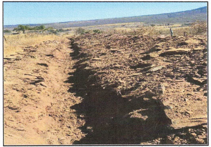
EXCAVACIÓN DE ZANJA PARA COLOCACIÓN DE TUBERÍA.
