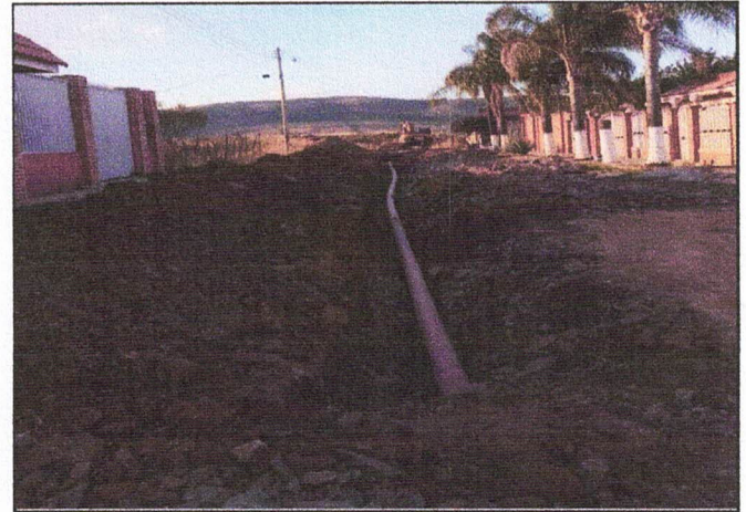
COLOCACIÓN DE TUBERÍA SANITARIA PVC DE 10"
