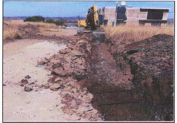
EXCAVACIÓN DE ZANJA PARA COLOCACIÓN DE TUBERÍA.
