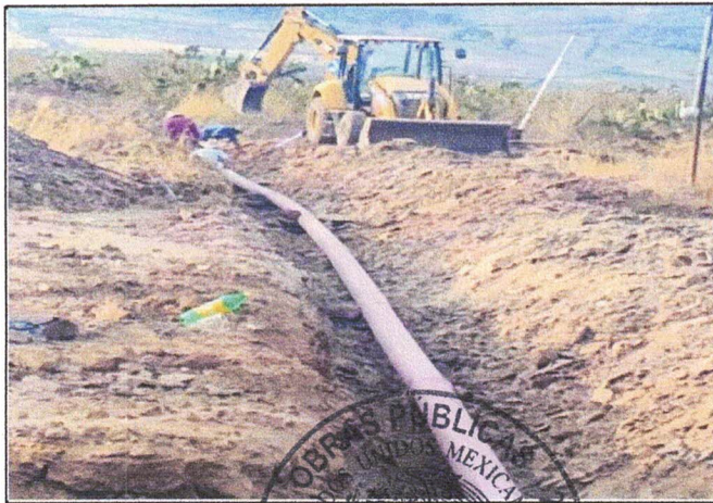
COLOCACIÓN DE TUBERÍA SANITARIA PVC DE 10"
