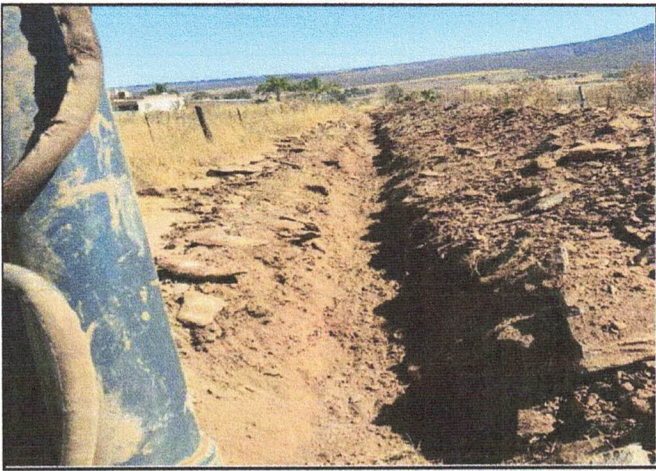
EXCAVACIÓN DE ZANJA PARA COLOCACIÓN DE TUBERÍA.
