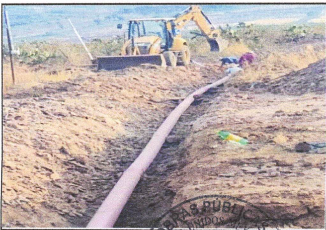
COLOCACIÓN DE TUBERIA SANITARIA PVC DE 10"
